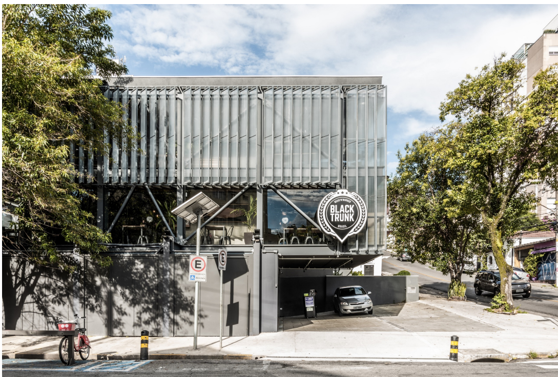
Figura 2. Vista lateral mostrando os brises em policarbonato alveolar. Fotógrafo – Guilherme Pucci
